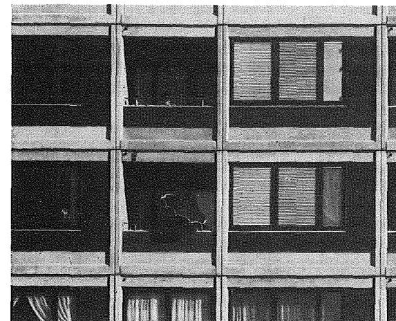
Ydervægskonstruktion af færdigfabrikerede betonelementer.
